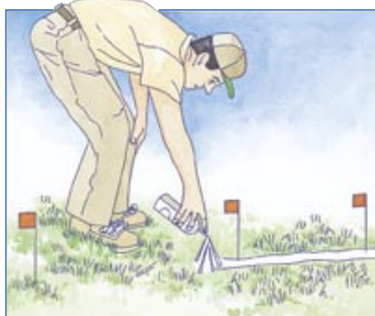
Antes de hacer la zanja, utilice pequeñas banderas y pintura en aerosol para marcar para hacer un esquema del sistema de riego.
