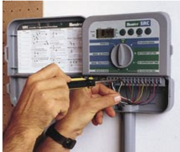
Utilice un cable de riego codificado para conectar las válvulas con el programador. Usted necesitará un cable para cada válvula, más un cable común.
